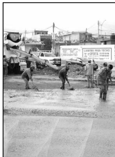
Se están pavimentando calles
